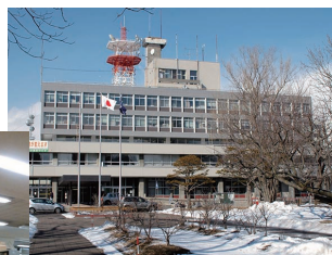
▲耐震工事の終わった釧路市役所
