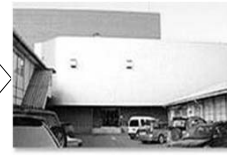
データセンター
